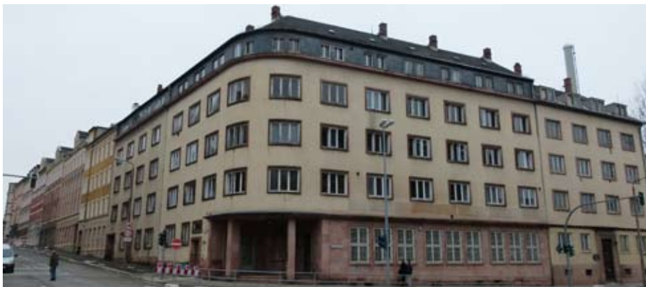
Diese Ecke Augustusburger/Zietenstraße saniert Fassmann als Wohn- und Arbeitsräume für kreative Fachkräfte, die Chemnitz trotz seines Potentials fehlen.
