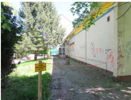
Anwohner Eckart Roßberg fotografierte das verwahrloste Gebäude.
