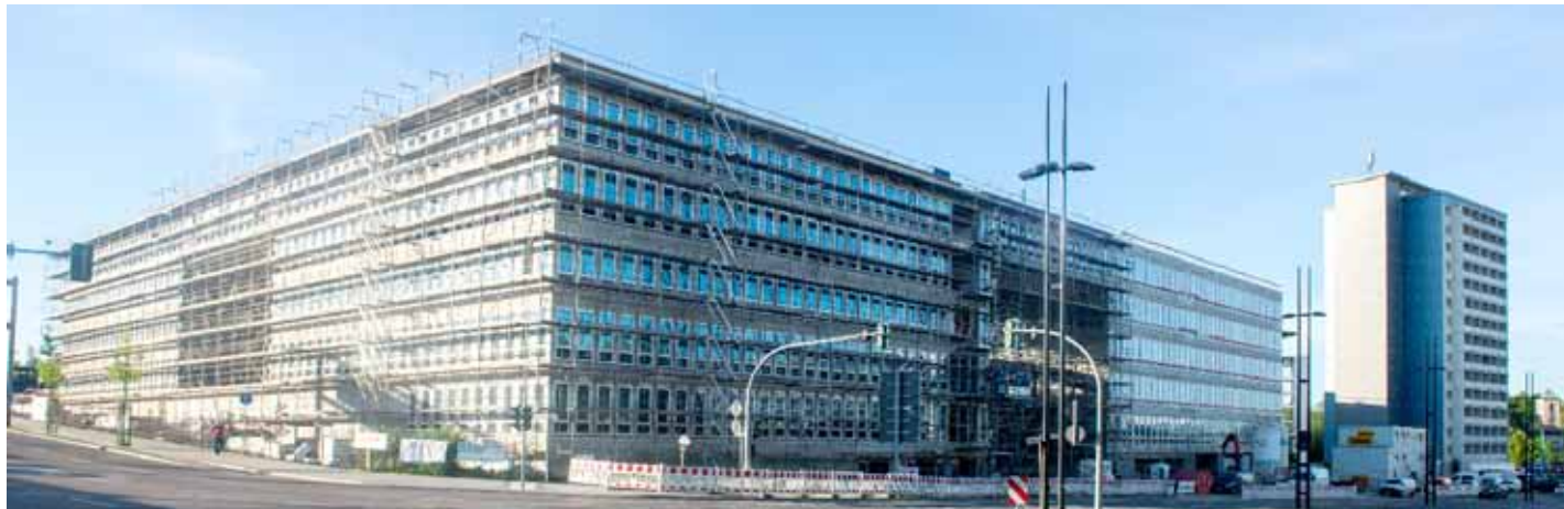
Am neuen Technischen Rathaus wird fleißig gearbeitet. Rechts im Bild entlang der Bahnhofstraße entsteht ein breiter Gehweg mit Bäumen.
