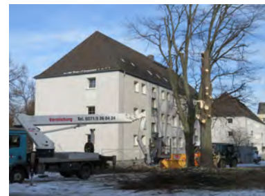
Würzburger Straße 56-62 - Beginn der Bauarbeiten und Baumfällung
