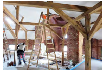
Ausbau der Turmstube
