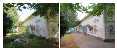
Ehemalige EDEKA-Kaufhalle an der Würzburger Straße 46.
