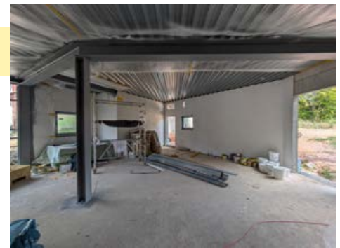
Blick in den künftigen Küchenbereich der Kiez-Kantine, derzeit noch Baustelle.
